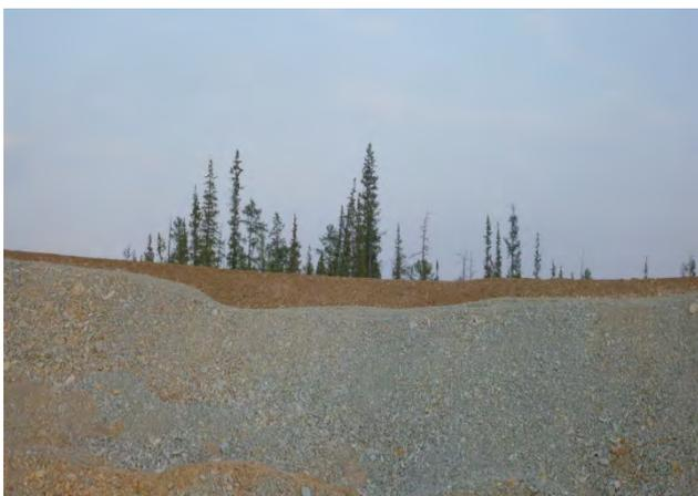
Рис. 4. Деформация железнодорожного полотна в результате дезинтеграции пород, слагающих насыпь (ПК-7486).
