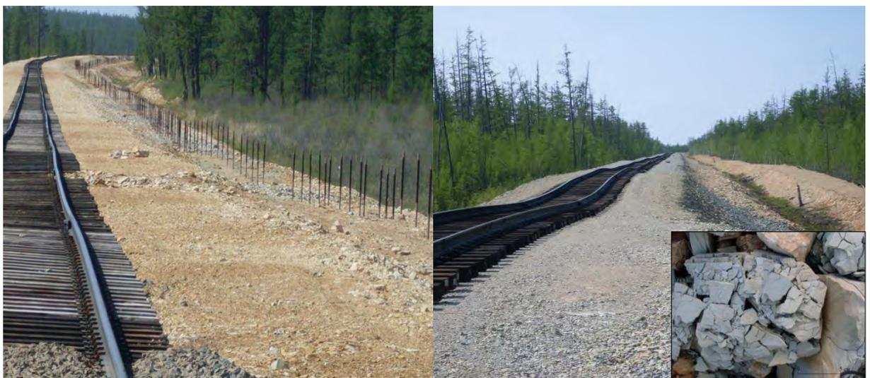
Рис. 3. Деформации полотна железной дороги, вызванные разрушением строительного камня под действием процессов криогенного выветривания (слева – ПК-6574, справа – ПК-6800 – в тело насыпи укладывался геотекстиль).
