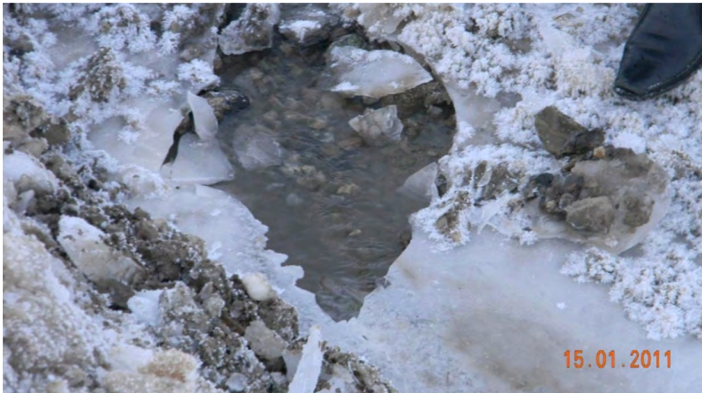
Рис. 13. Водоприток по водоотводной канаве, 15.01.2011, температура наружного воздуха -40^{\circ}\text{C}
