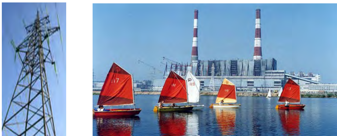
Рис. 5. Нерюнгринская ГРЭС – энергетическое сердце Южной Якутии
