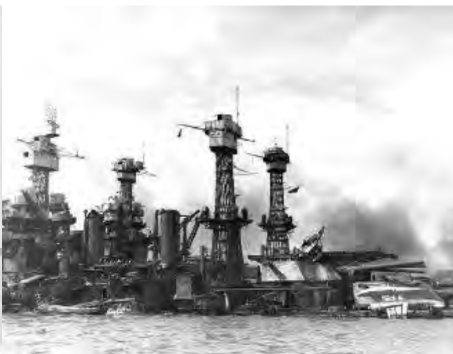
Гиперboloидные мачты американского линкора «Западная Вирджиния» (BB-48), Пёрл Харбор, 1941
