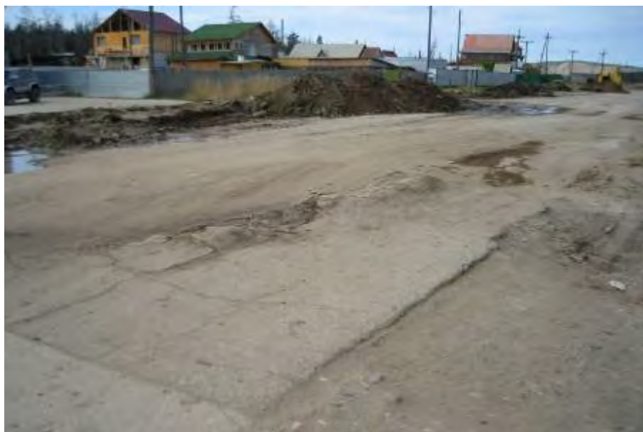
Рис. 1. Пучение, просадки, плавунные грунты
