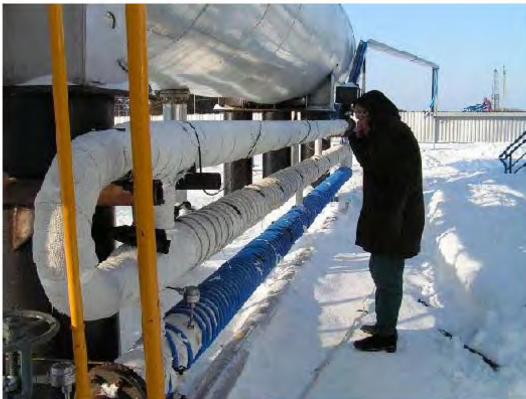
Рис. 2. Фрагмент монтажа индуктора
