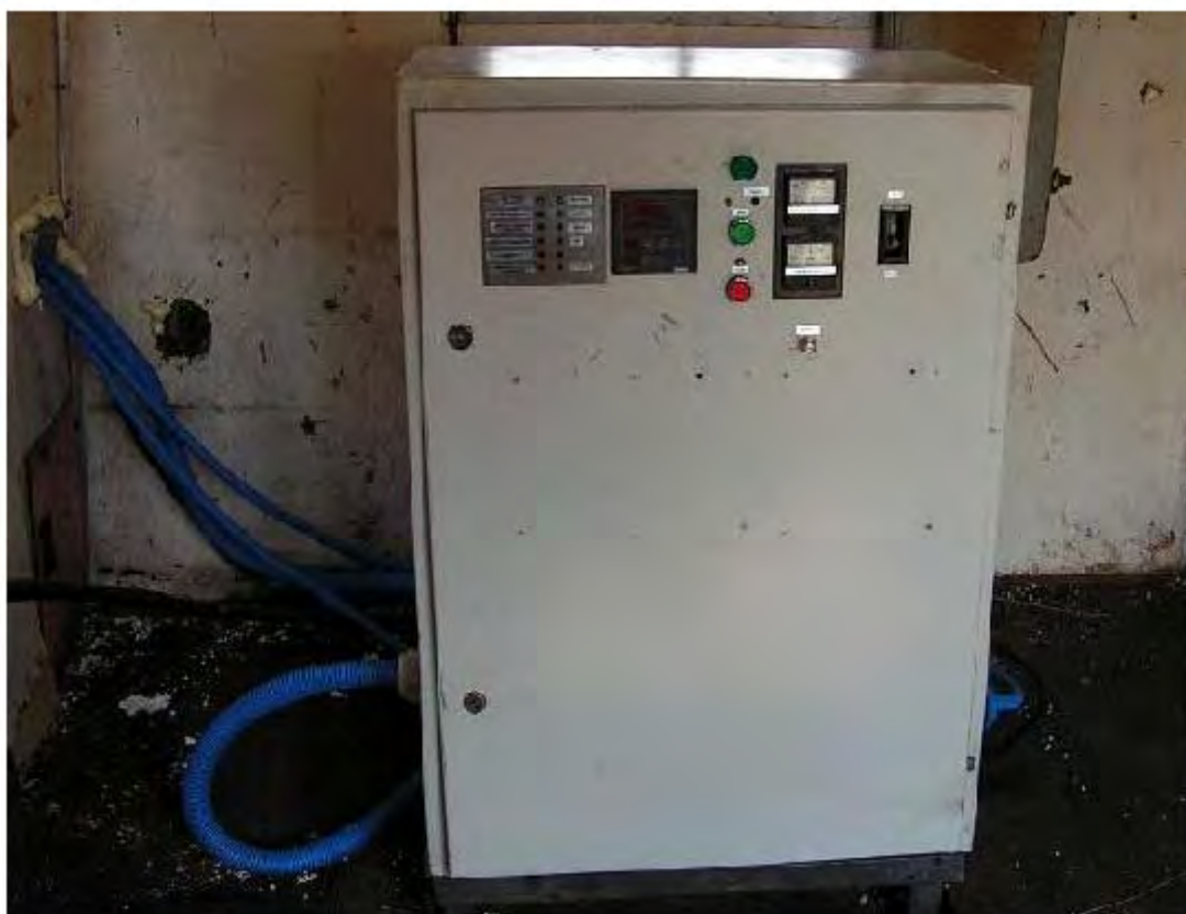
Рис. 1. Источник мощностью 30 кВт для питания индуктора нагревателя
