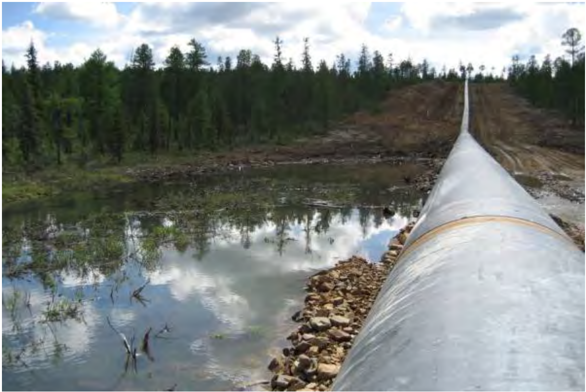
Рис. 2. Обводнение и заболачивание у нефтепровода
