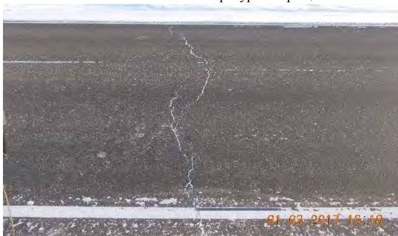
Рис. 2. Трещина на асфальтобетонном покрытии вследствие перепада температур
