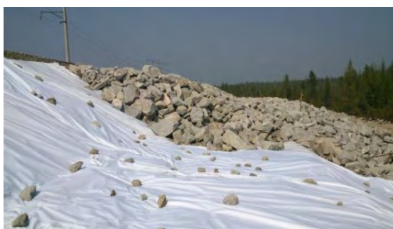
Рисунок 1 - Отсыпка насыпей из самоохлаждающихся грунтов
