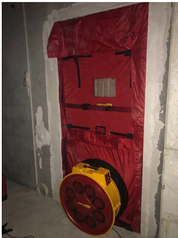
Рис.1 «Аэродверь «Retrotec 5000», установленная в дверной проем»
