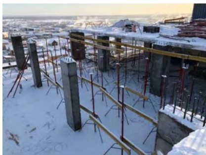
Рис. 2 Установка стоек с треногами
