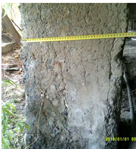
Рис. 1. Свая – ул. Ярославского 39, г. Якутск
