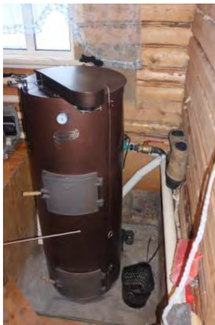
Рис. 2. Твердотопливный котел «Liepsnele» с мощностью 20 кВт, установленный в с. Балаганнах
