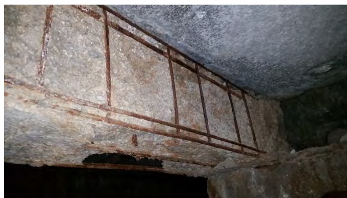
Рис 2. Рандбалка – ул. Ярославского 39/1, г. Якутск
