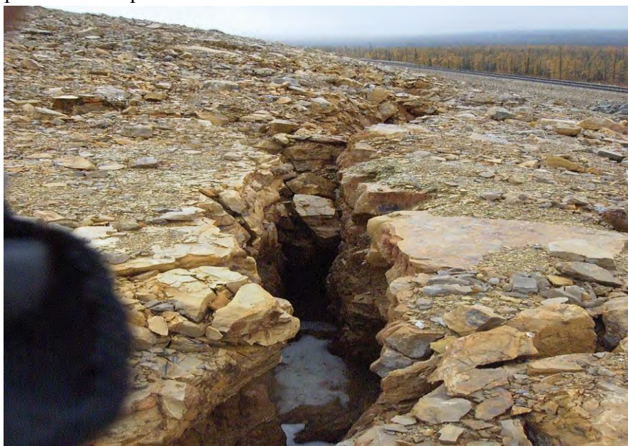
Рис. 1. Трещина отседания на 116 км железнодорожной трассы Беркакит-Томмот
