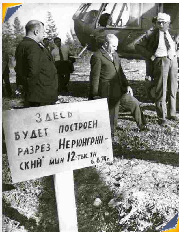
Министр угольной промышленности СССР Братченко Б.Ф. на закладке нового разреза «Нерюнгринский», 6 августа 1974г.
