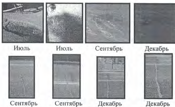
Рис.1. Мониторинг выбоины и трещины с июля по декабрь 2007г.
