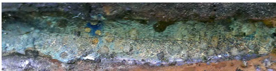
Рис. 2. Общий вид образовавшейся трещины на жёсткой пробе «Теккен»
