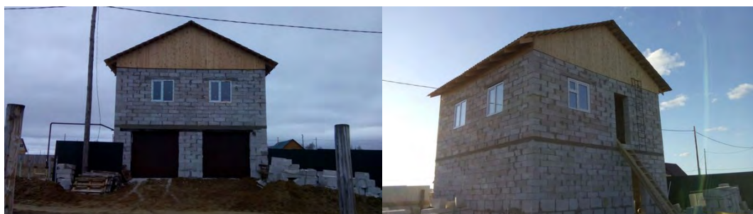
Рис. 2. Наружный вид застройки в поселке Жатай
