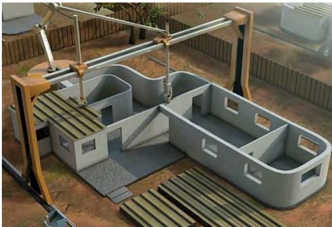
Рисунок 1. Возведение стен 3D принтером.
