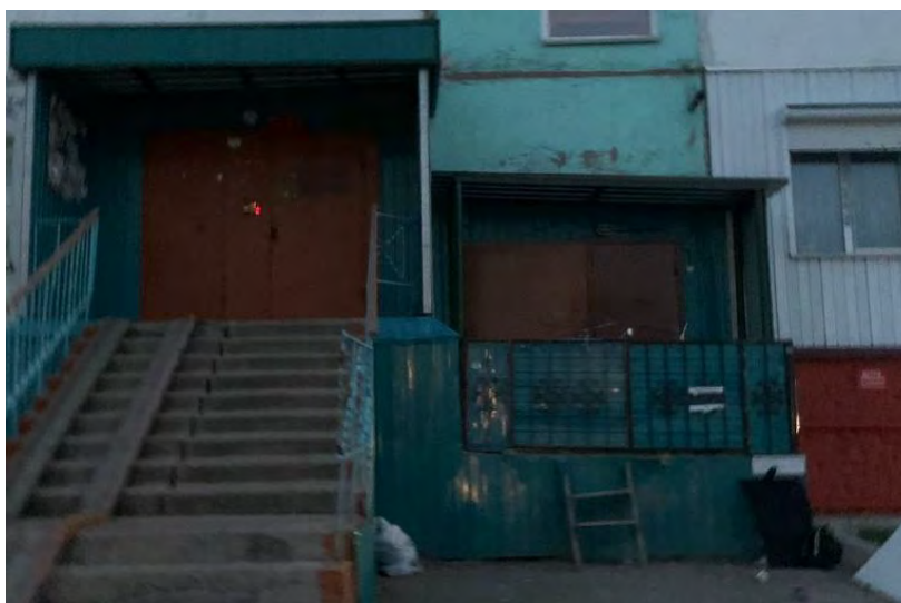
Рис. 3 Подвал жилого дома
