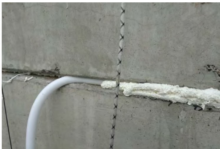
Рис. 3. Герметизация межпанельных швов
