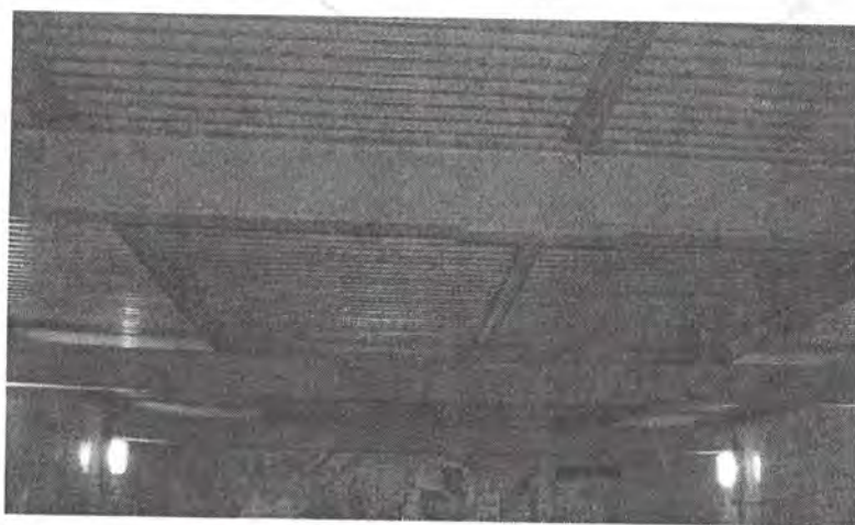
Рис.10. Общий вид конструкций покрытия бассейна СОШ № 15
