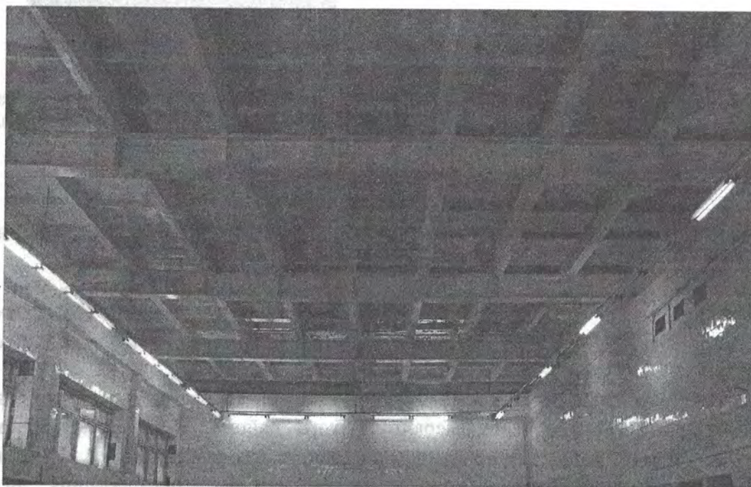
Рис. 2. Общий вид конструкций покрытия бассейна СОШ № 2
