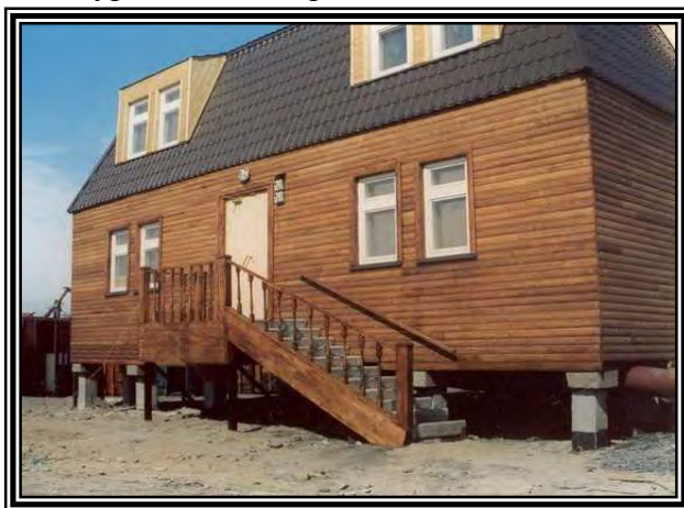
Рис. 3. Жилой дом для временного проживания в г. Певек
