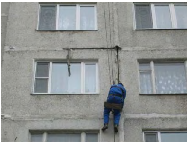
Рис. 3. Технология расшивки межпанельного шва
