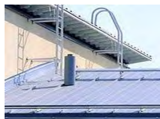
Рис. 2. Фальцевая кровля
