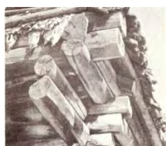
Рис. 4. Сруб постройки амбара
