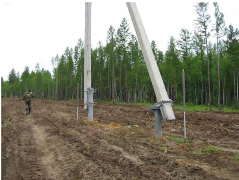
Рис. 4. Устойчивое состояние опор ЛЭП по трассе ВС-ТО. Фото И.В. Дорофеева
