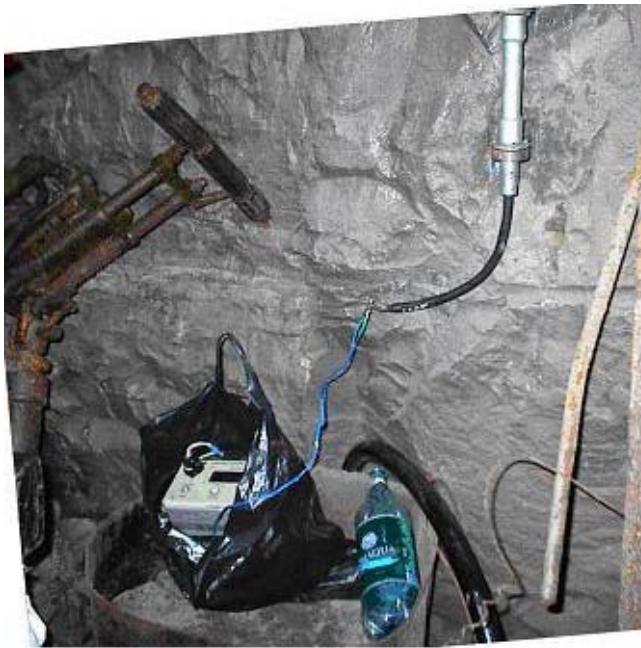
Рис. 1. Деформометр ТБ-200 ВНИИГ №1005 установлен на высоте 1,5 м от основания на пикете ПК 4+6 по правой стороне штольни №2 В левом нижнем углу фотографий находится цифровой периодомер ПЦП-1.
