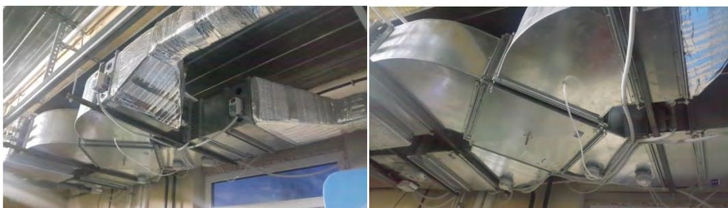
Рис. 4. Приточно-вытяжная система вентиляции частного дома в г. Якутске
