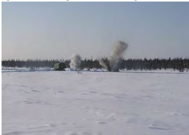
Рис. 1. Проходка шурфов буровзрывным способом
