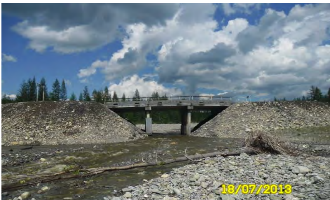
Рис. 1. Общий вид моста через реку Малиновка на 552+482 км автомобильной дороги «КОЛЫМА» Якутск-Магадан
