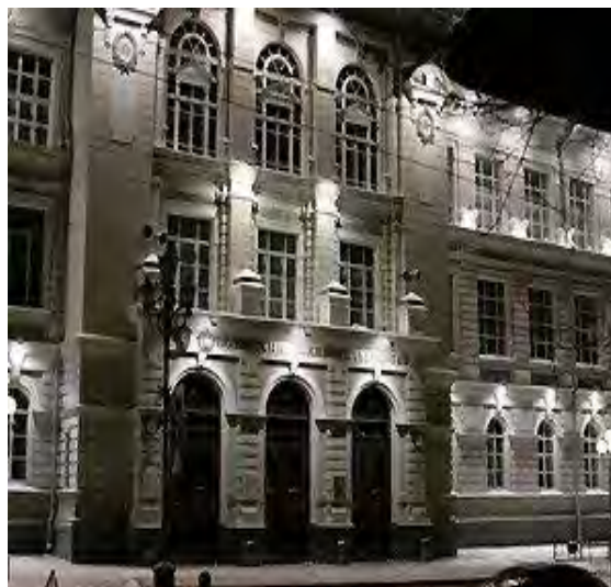
Рис. 2. Главный корпус НИ ТПУ
